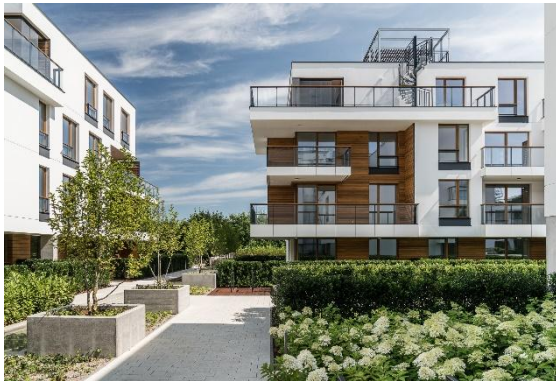
fot. kubatury B2 i B1, widok od strony północno-wschodniej
